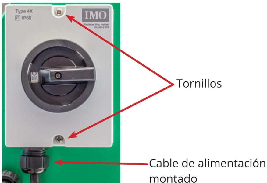
Hay un prensaestopas exclusivo para su cable de alimentación. Pasar el cable por él con una longitud suficiente para poder trabajar cómodamente. Luego pela el cable 5cm de aislamiento (total) y los hilos de cobre 1 cm.
